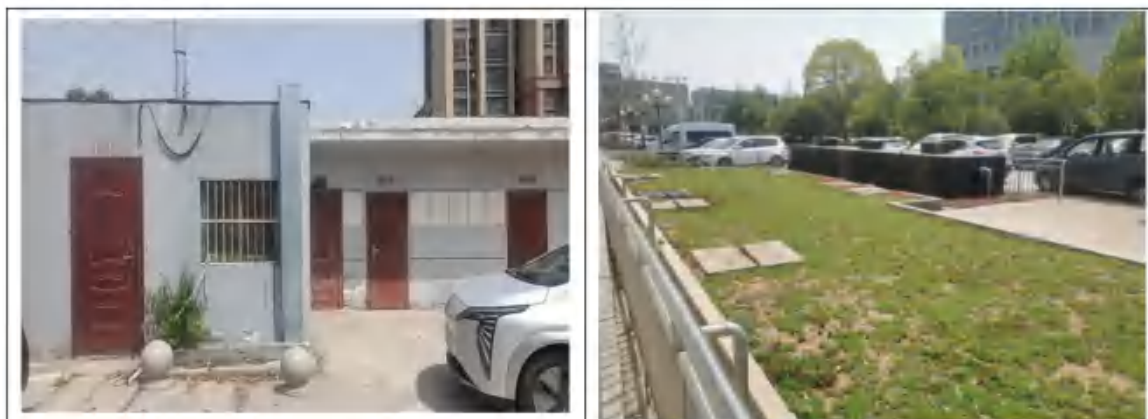
图 11-1 污水处理站建设情况
