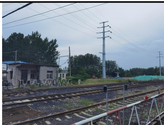
南坪-湛为线敷设起点（10#杆塔）
