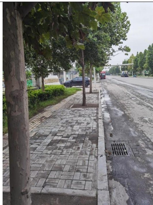
藕池-湛为线电缆段生态修复
