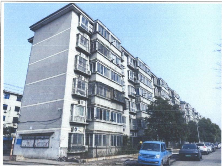
淮北市烈山区临海童街道临选厂社区临涣选煤厂东村 26#6 层平顶居民楼
