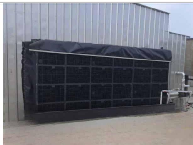
猪舍废气除臭墙
