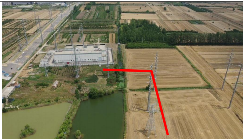
220kV 藕池变位置（接入端）
