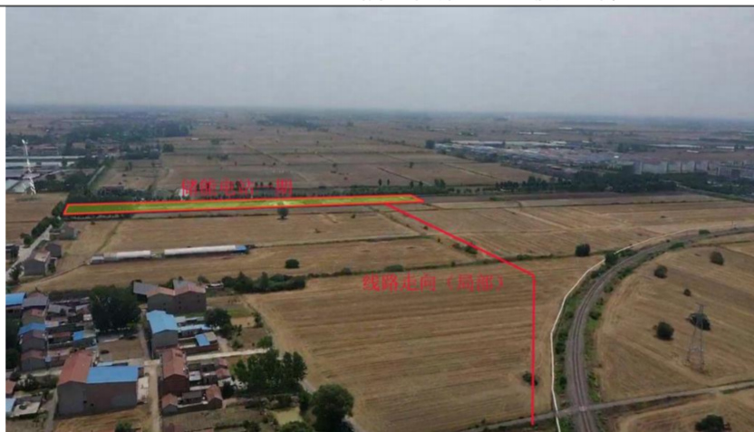
储能电站（送出端）
