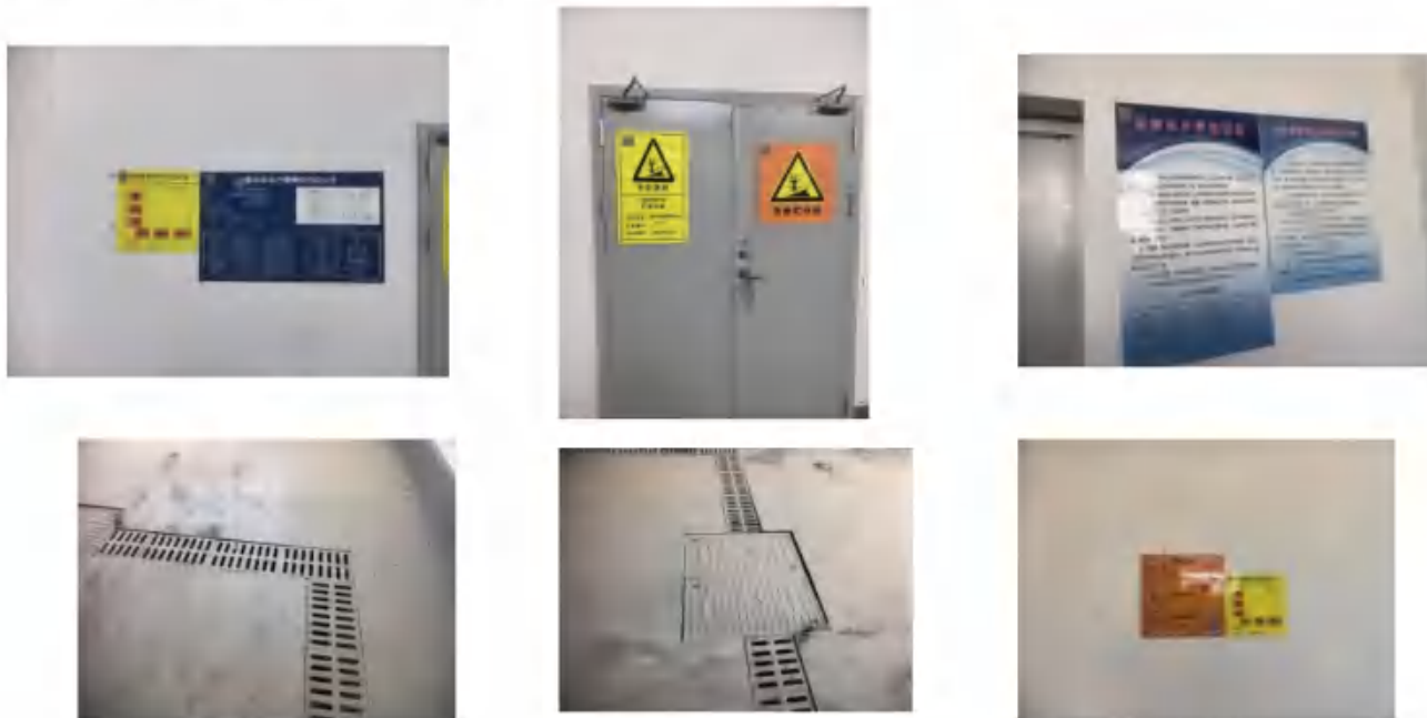
危废暂存间现场照片
