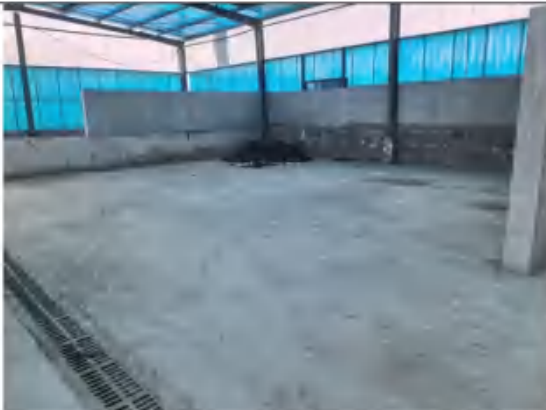
堆肥车间（采用防渗混凝土）
