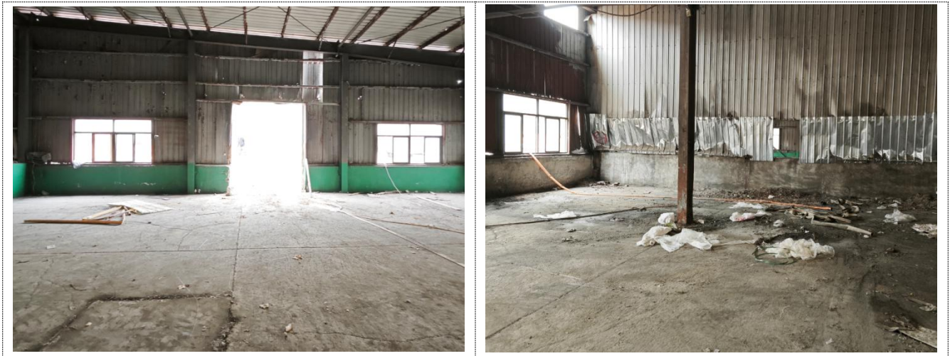
图 3-4 厂区地面硬化破损及墙面破损情况示意图
