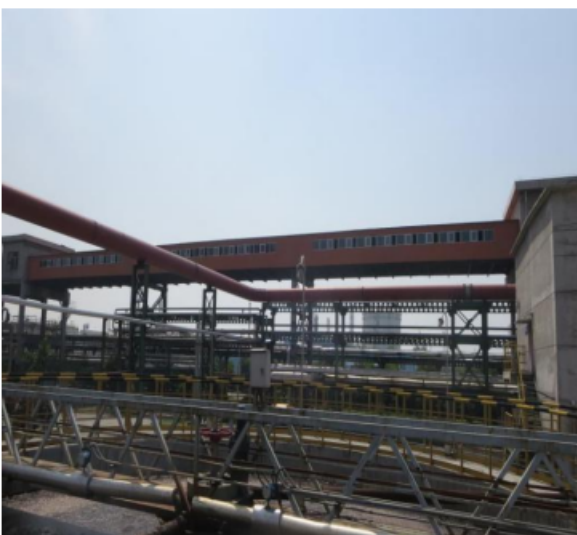
封闭式焦转运通廊
