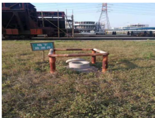
熄焦塔（8号焦炉东侧）
