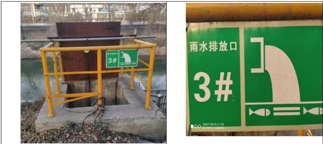
图 3.4-7 废水处理措施部分现场图
