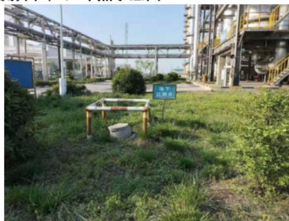
罐区(二期甲醇)
