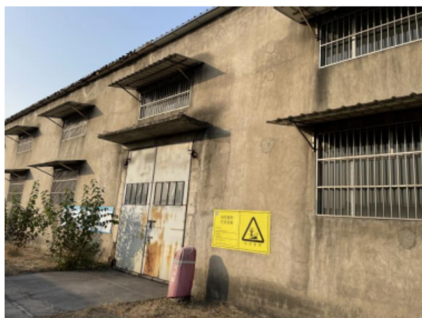
危险废物暂存库
