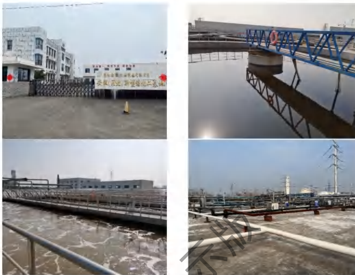
图 5.2-14 园区污水处理厂（鑫远）现场图片
