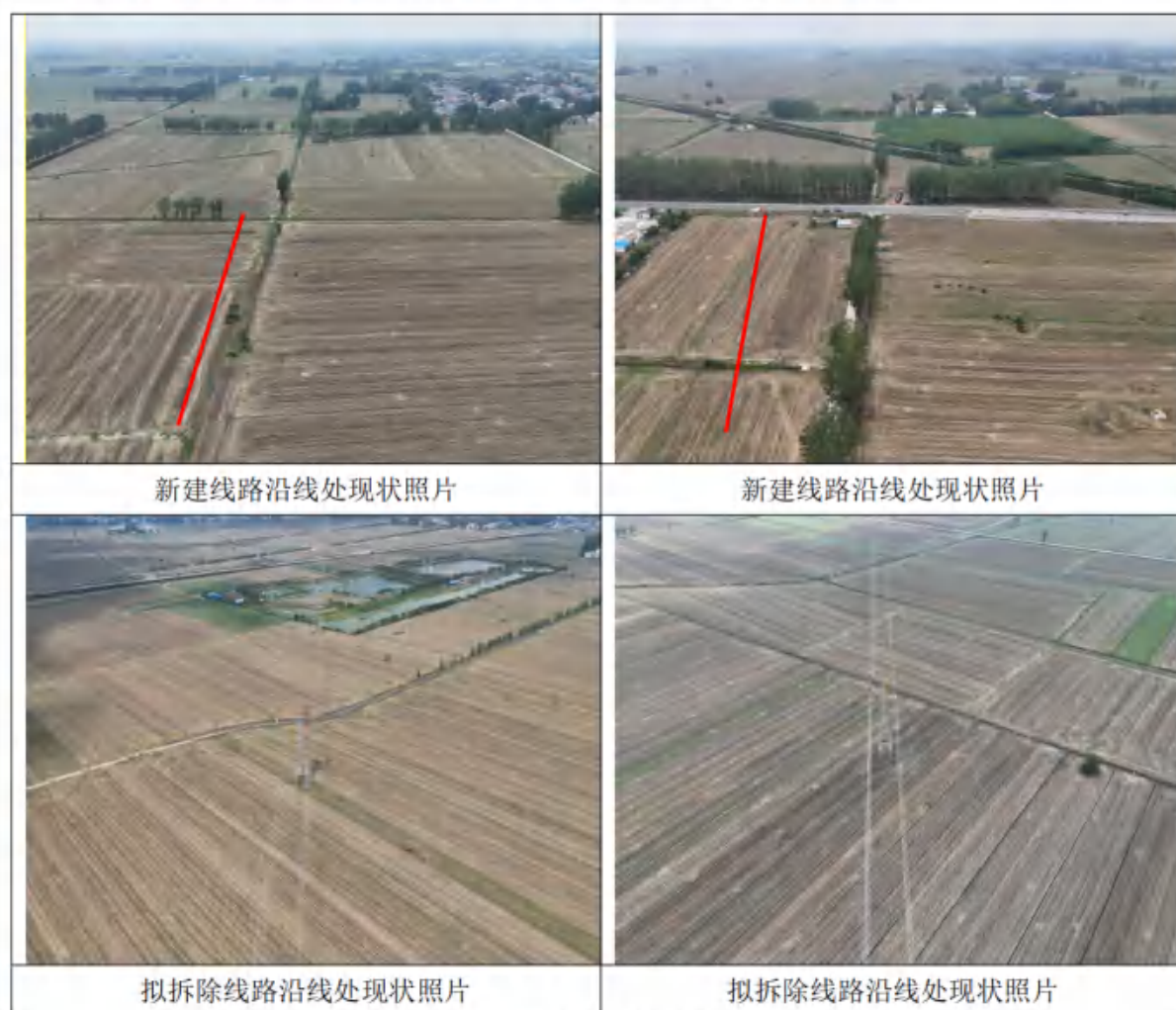
图 3-1 线路沿线现状照片
