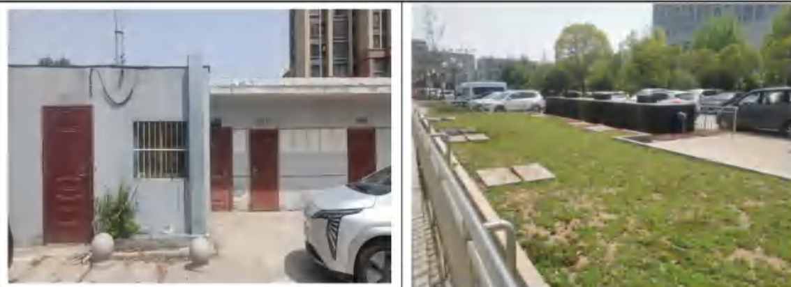
图 11-1 污水处理站建设情况
