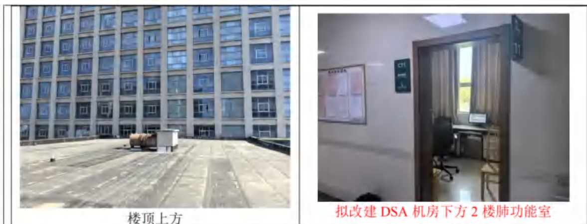
图 8-1 本项目机房及周围环境现状图
