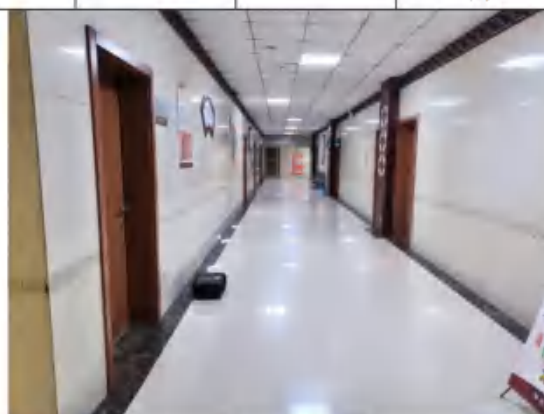
西侧现状走廊
