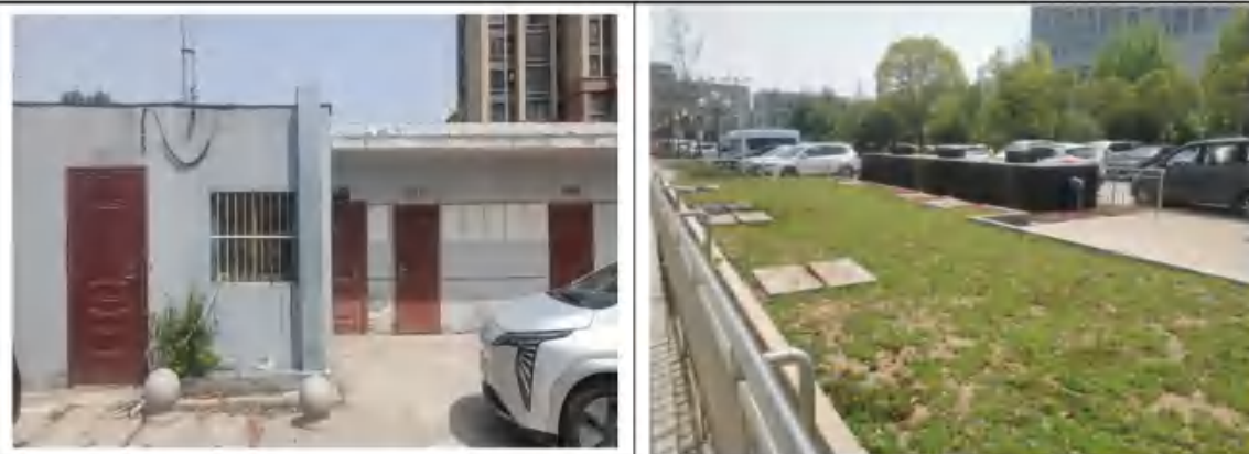
图 11-1 污水处理站建设情况
