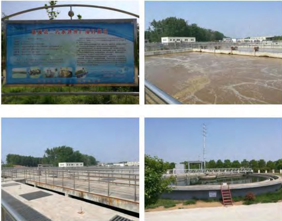
图 2.3-6 濉溪第二污水处理厂现状照片
