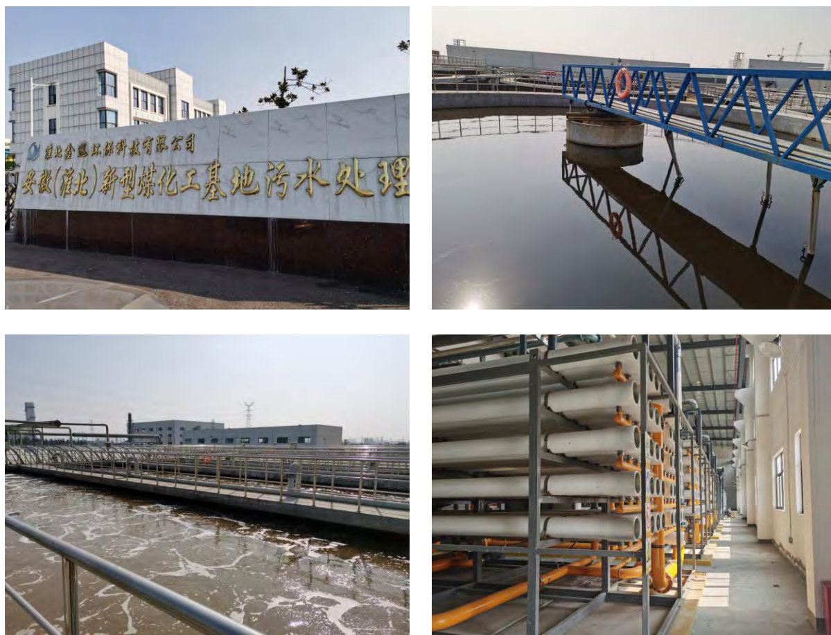
图 2.3-8 煤化工基地污水处理厂现状图片
