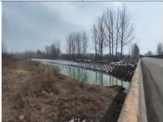
图 3-1 线路跨越大庙沟处现状照片 3
