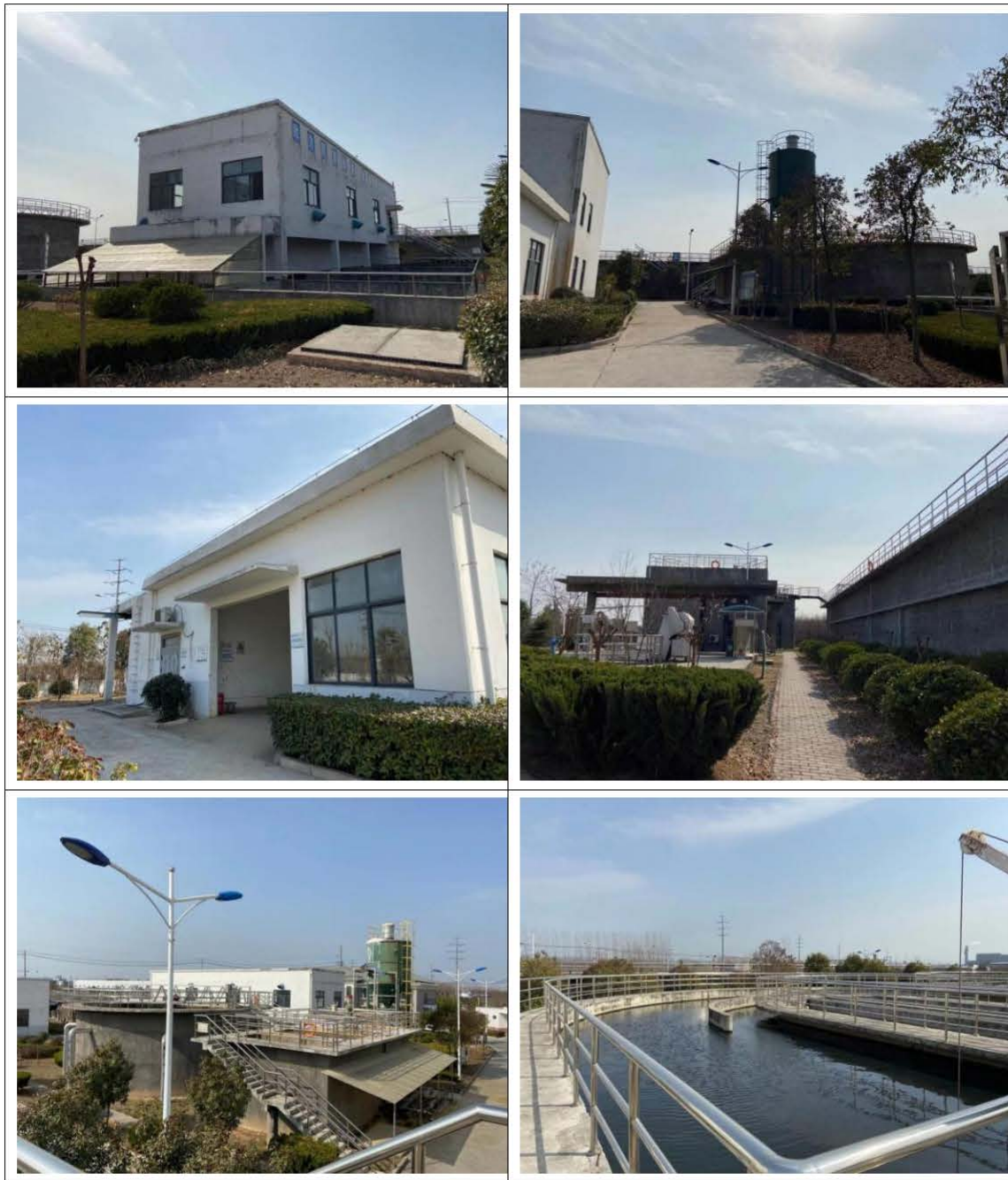
图 3.2.3-2 淮北经济开发区新区污水处理厂现状照片
